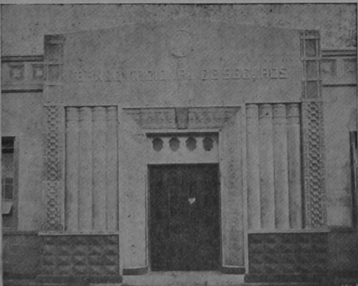
Detalles de la portada del edificio
